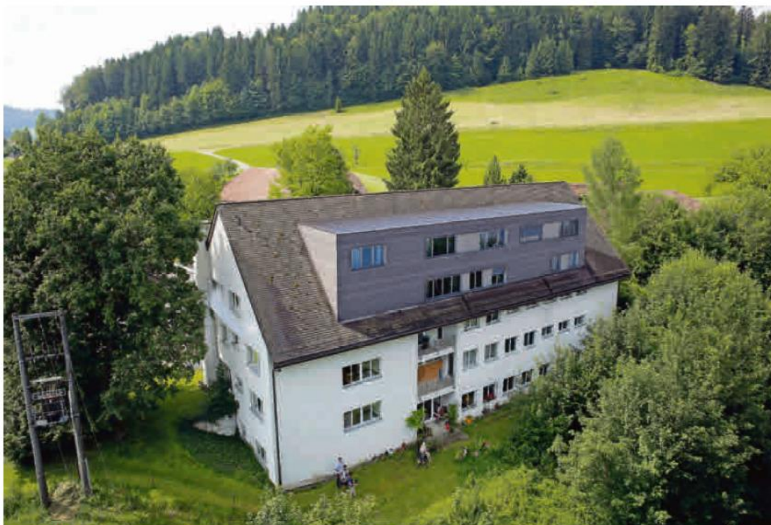
Im Haus Birke werden im Dachgeschoss fünf neue Zimmer und ein Dachaufbau gebaut.
